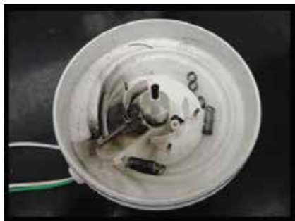
Se evidencia mal uso de la ducha
